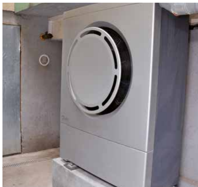
2 Powietrzna pompa ciepła DHP-AQ.
