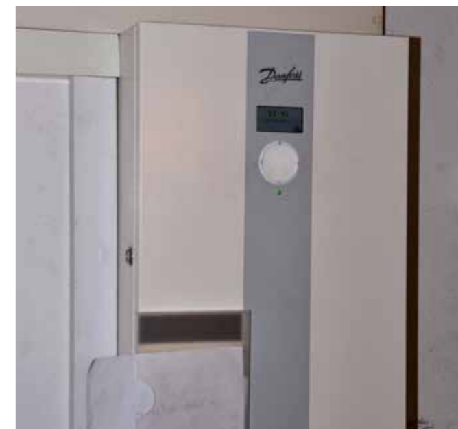
4 Panel sterowania powietrzną pompą DHP-AQ.
