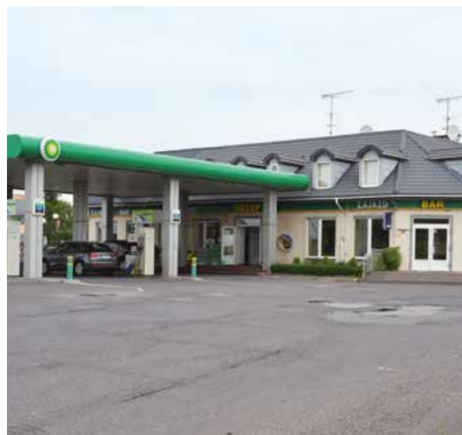
1 Stacja paliw w Sierpowie ogrzewana pompami DHP-AQ.
