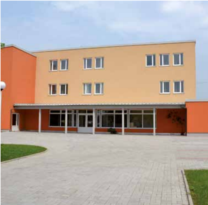
5 Hotel 105, ogrzewany i chłodzony powietrznymi pompami ciepła DHP-AQ Danfoss.
